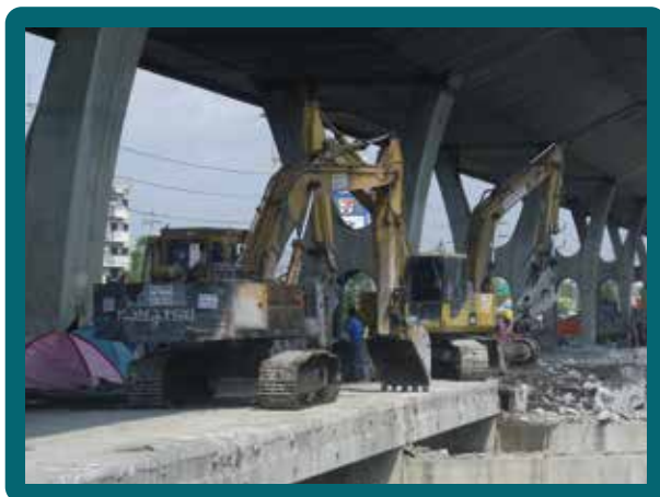
รับรื้อถอนโครงสร้างเหนือพื้นดิน โครงสร้างใต้พื้นดิน รับรื้อถอนถนนและสะพาน Demolition for superstructure, underground structure, road and bridge
