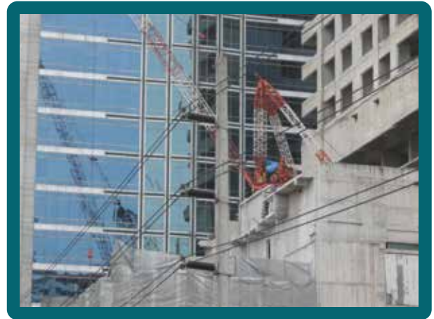
รับรื้อถอนอาคารสูง อาคารขนาดใหญ่ สิ่งปลูกสร้างทุกชนิดและทุกประเภท Demolition for high-rise building and large building.
