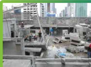
วิธีการตัดโครงสร้าง พื้น คาน เสา บันได และปล่องลิฟท์ Concrete cutting for slab, beam, column, stair and shear wall.
