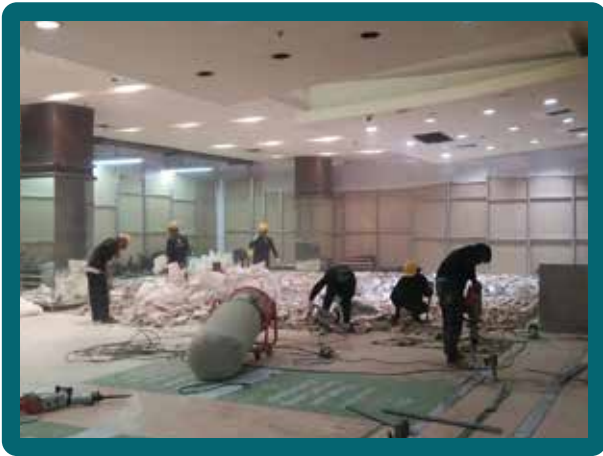
รับรื้อถอนงานโครงสร้าง งานสถาปัตยกรรม งานตกแต่งภายใน งานระบบ M&E Demolition for structural, architectural and M&E system work
