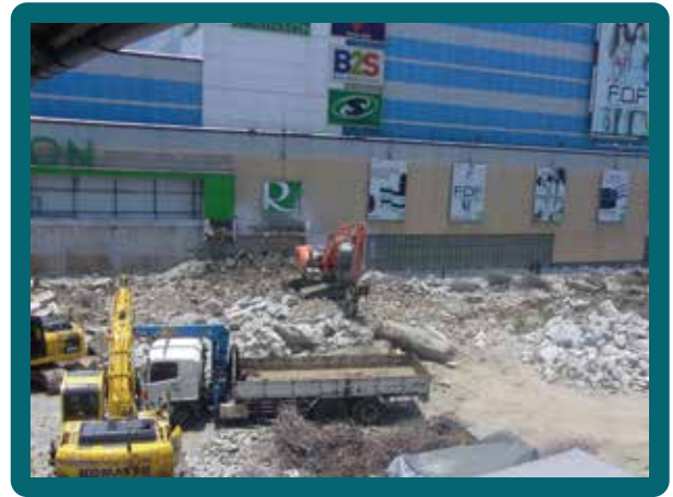
รับรื้อถอนอาคารที่อยู่อาศัย อาคารพาณิชย์ โรงงานอุตสาหกรรม ห้างสรรพสินค้า Demolition for residence, commercial and industrial building.
