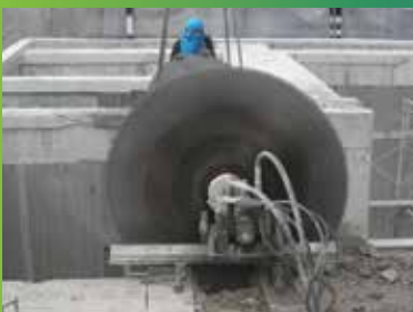
วิธีการตัด และเจาะคอนกรีต Concrete cutting and coring work.
